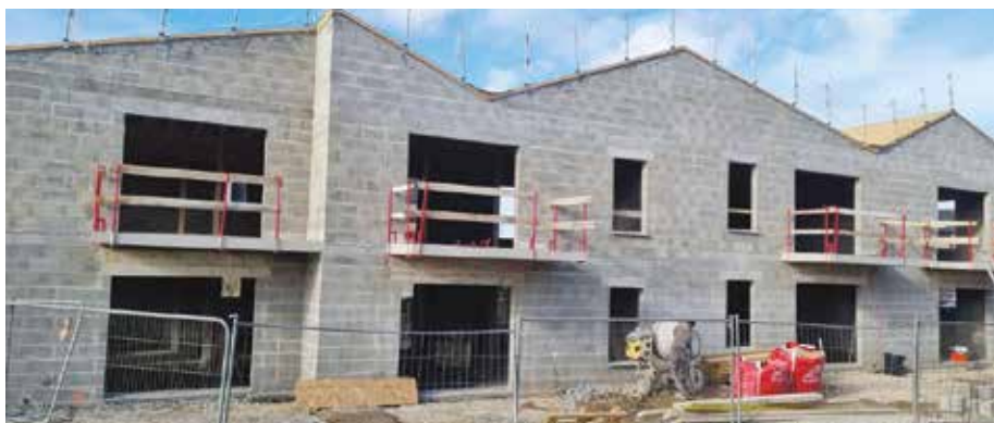
Construction à Plomodiern
